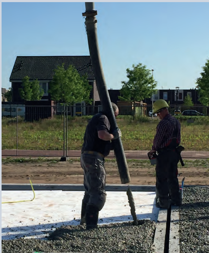
Begin juni: het storten van de beganegrondvloeren.
