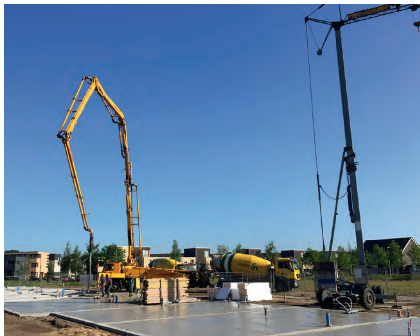
Het project van Lamers in aanbouw, begin juni 2015.
